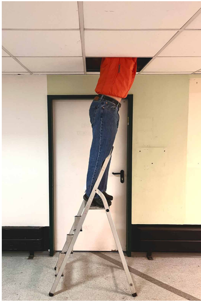
Eingehende Gebäudeanalysen bilden die Grundlage für jede Intervention.
