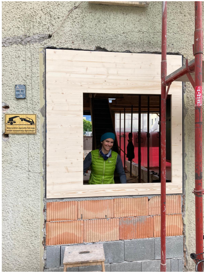
Gemeinsam mit Handwerker*innen entstehen Details, die direkt aus dem Bestand heraus entwickelt sind.
