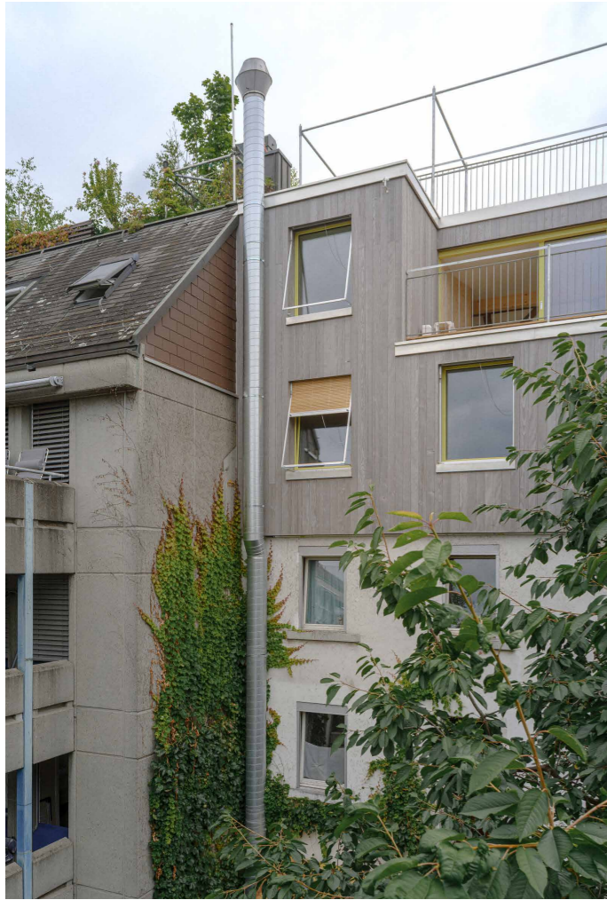
Es wird nur verändert, was notwendig ist – Eingriffe ergänzen den Bestand, statt ihn zu ersetzen.
